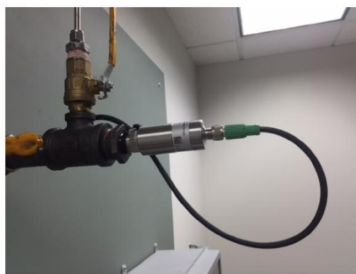
Рисунок 15 Е + Е Влагозащитный индикатор Рисунок 16 Е + Е Установленный зонд
