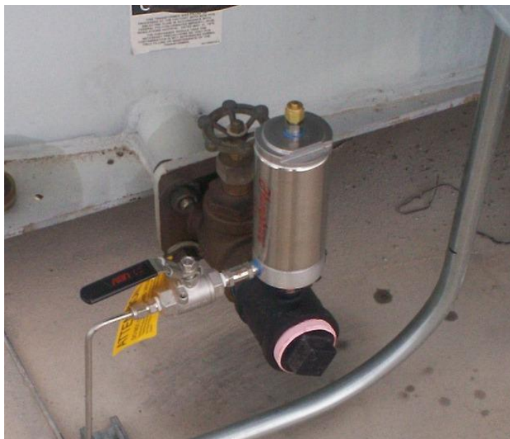
Рисунок 3: Установленный воздухоотвод
