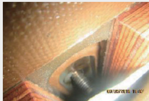
图1： A相铁芯夹件 螺丝上的松动 螺母
