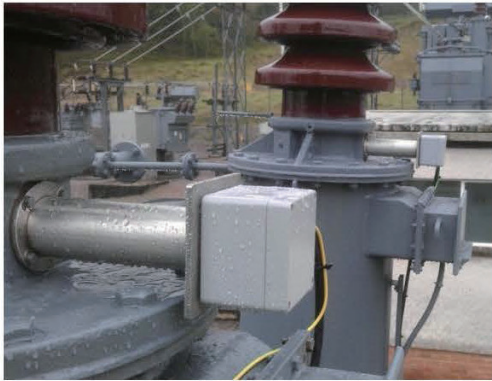
图10 安装在套管分接头上的适配器允许双端行波 (TW) 故障定位
