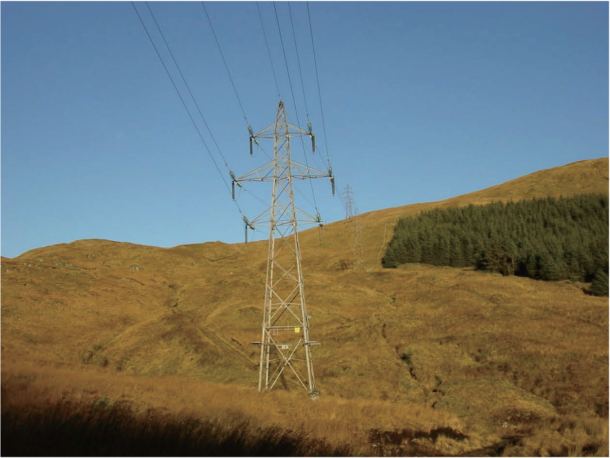
图2 Dunoon的T接线路段上的132KV铁塔
